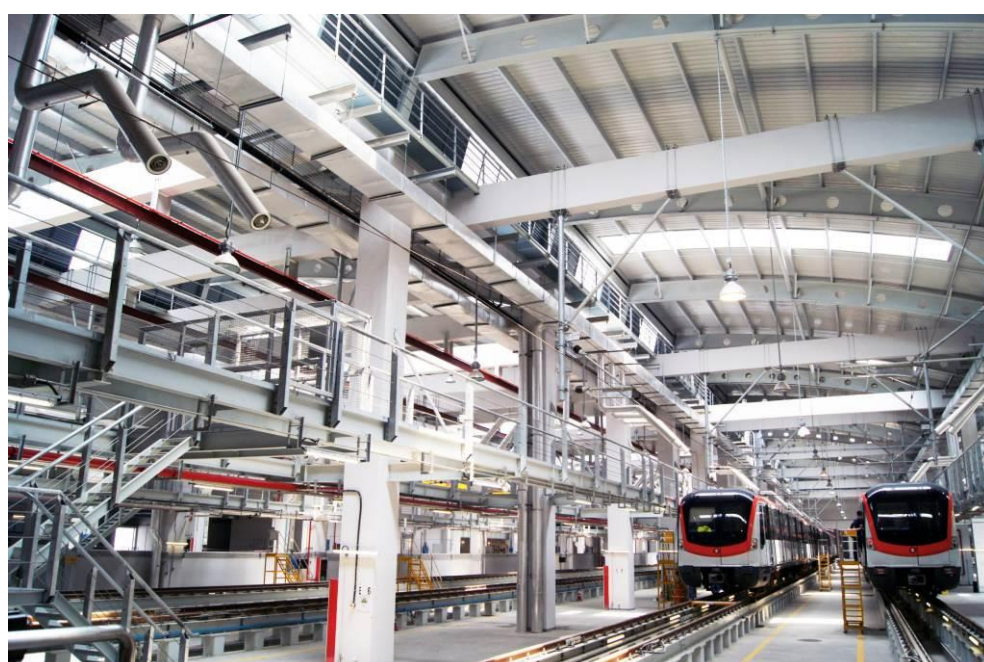
图片：港铁（深圳）车厂
